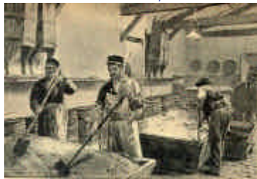
Le mélange des matières vitrifiables aux Cristalleries de Pantin. Doc. A. Collombar
